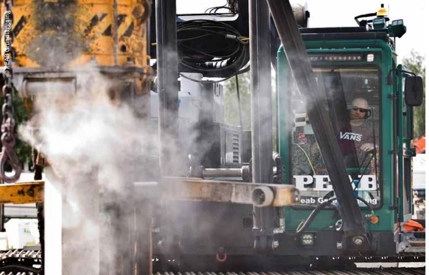
Otro pilote se coloca en la parte superior del primero. El suelo de arcilla vibra, y la pieza de madera que actúa como amortiguador entre dos pilotes, se incendia debido a la fricción. Afuera, el ruido es casi doloroso, pero Bergman asegura que a él no le molesta dentro de la máquina.
